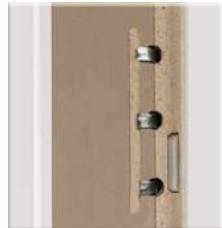
Schließblech Standard Ansicht Futterrückseite
