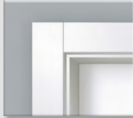
Konstruktionsfuge (stumpf gestoßen)
