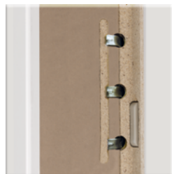
Schließblech Standard Ansicht Futterrückseite
