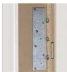
verstärktes Schließblech mit Stahlhalteplatte Nr. 35 Ansicht Futterrückseite
