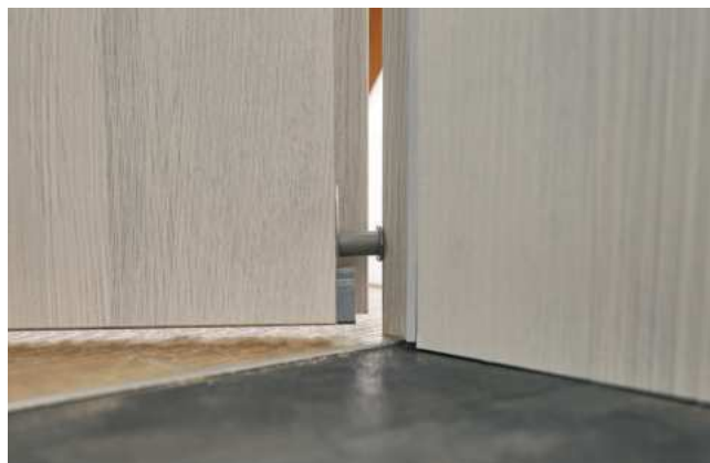
Bodendichtung Schalllex Auslöser
